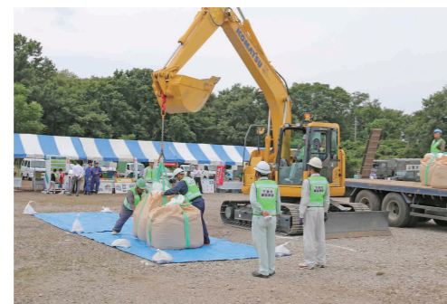
水害対策の大型土のう設置訓練
