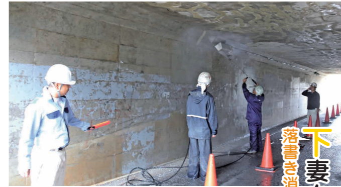
隧道の汚れを落とす隊員たち
