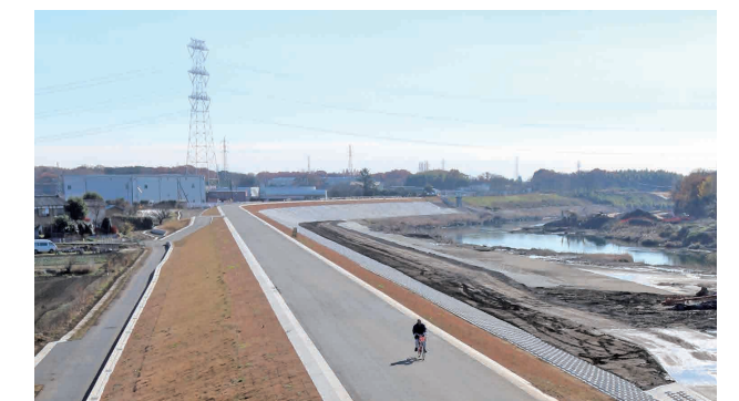
完成した前河原地区の堤防
