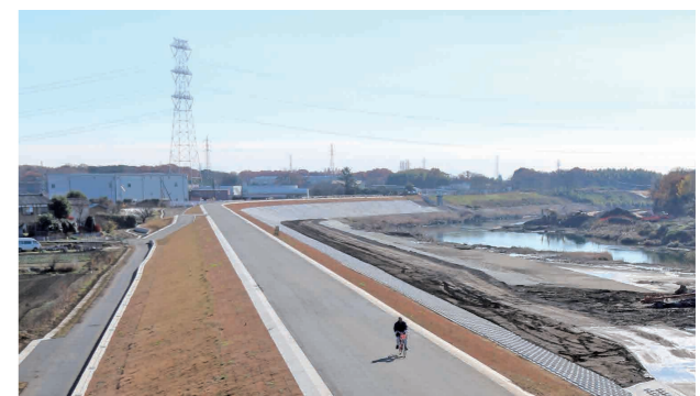
完成した前河原地区の堤防
