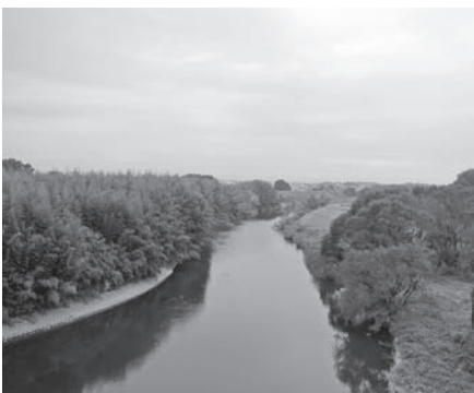
河川内の樹木伐採の実施が予定されている(小貝大橋付近の様子)
