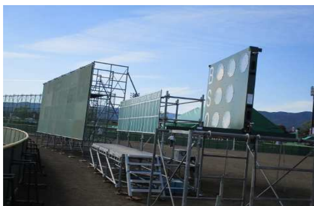
バックスクリーン・得点板等設置（仮設）
