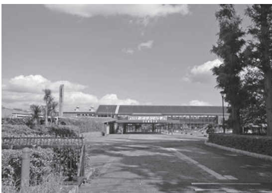
砂沼西岸の整備と合わせて茨城県と協議を行っていく
