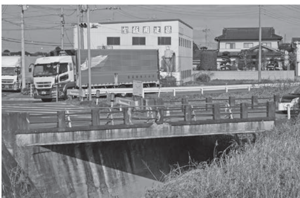
市道106号線に架かる月波橋（横根地内）
