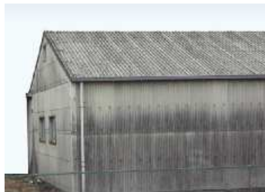
石綿含有スレート波板（屋根・外壁）
