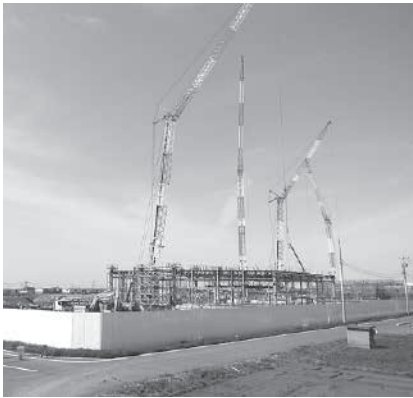
工場の建設工事が進むしもつま鯨工業団地
