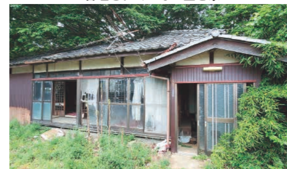
管理されていない空き家
