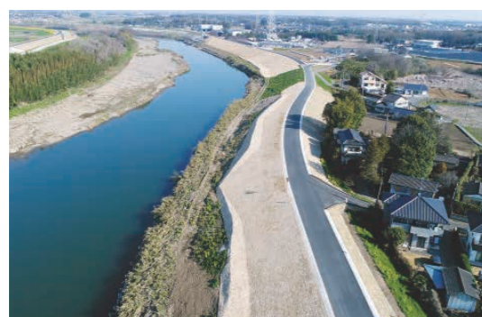
整備された堤防(長塚地区)
