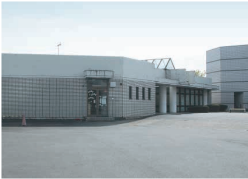
千代川庁舎南棟に設置されているスクールサポートセンター
