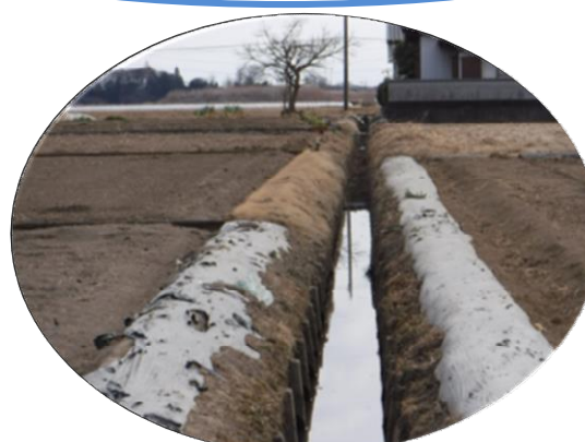
排水路泥上げ工事 【農地維持化活動】
