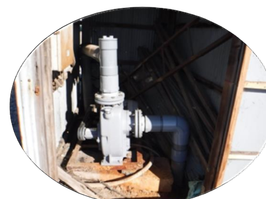
ポンプ更新工事 【長寿命化活動】
