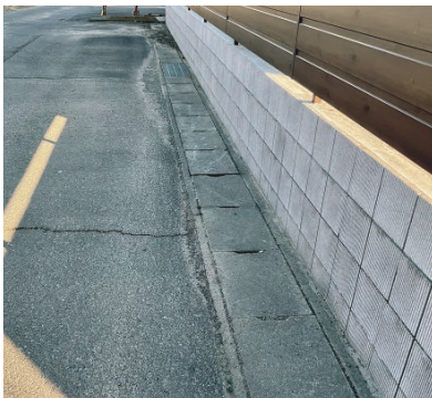
自治会等の協力により清掃が行われている道路側溝
