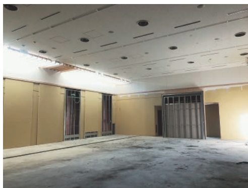
建設が進められている新議場内の現在の様子
