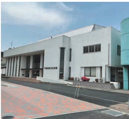
解体の方針が示された下妻市民文化会館
