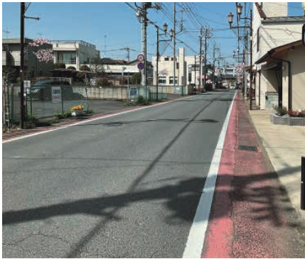
安全対策として実施している路側帯のカラー塗装
