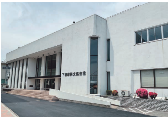
解体方針が示されている下妻市民文化会館
