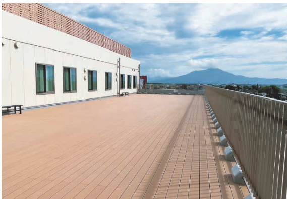
庁舎4階に整備された筑波山テラス
