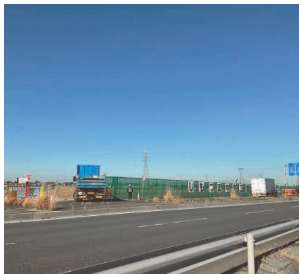
現在造成中のしもつま中央工業団地
