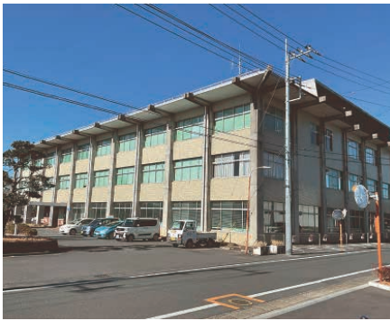
今後解体が予定されている旧本庁舎
