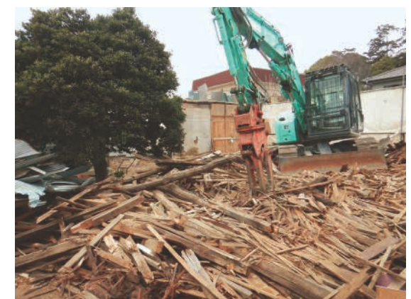
解体工事の様子
