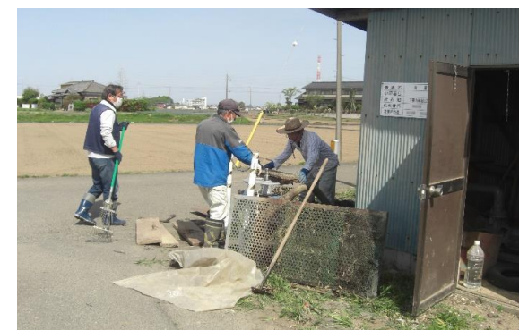
ポンプ施設の点検・機能診断 【準備・点検】
