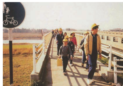
【昭和49年】 大形橋の南側に完成した歩行者専用道路
