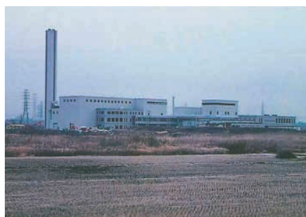
クリーンポート・きぬ竣工
