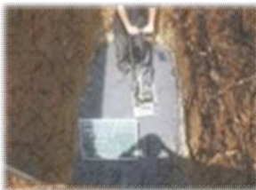
7-①. 底盤コンクリート出来形検測
