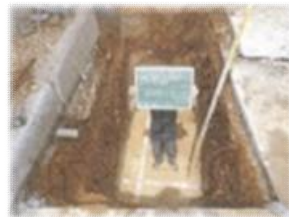
6. 底盤コンクリート型枠・配筋
