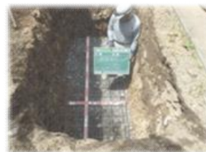
6. 底盤コンクリート型枠・配筋
