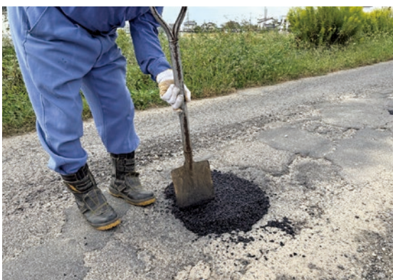
傷んだアスファルト舗装の修繕の様子
