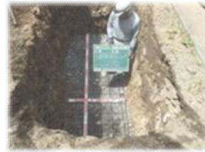
6. 底盤コンクリート型枠・配筋
