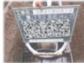
12. 上部砕石転圧・埋め戻し完了
