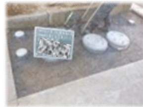
14. 上部スラブコンクリート出来形検測・厚み確認
