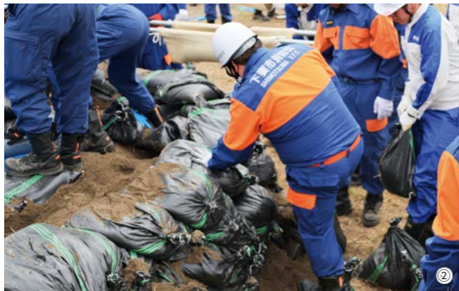
① 隊員協力によるスピーディーな土のうづくり ② 土のうを積み上げる月の輪工法
